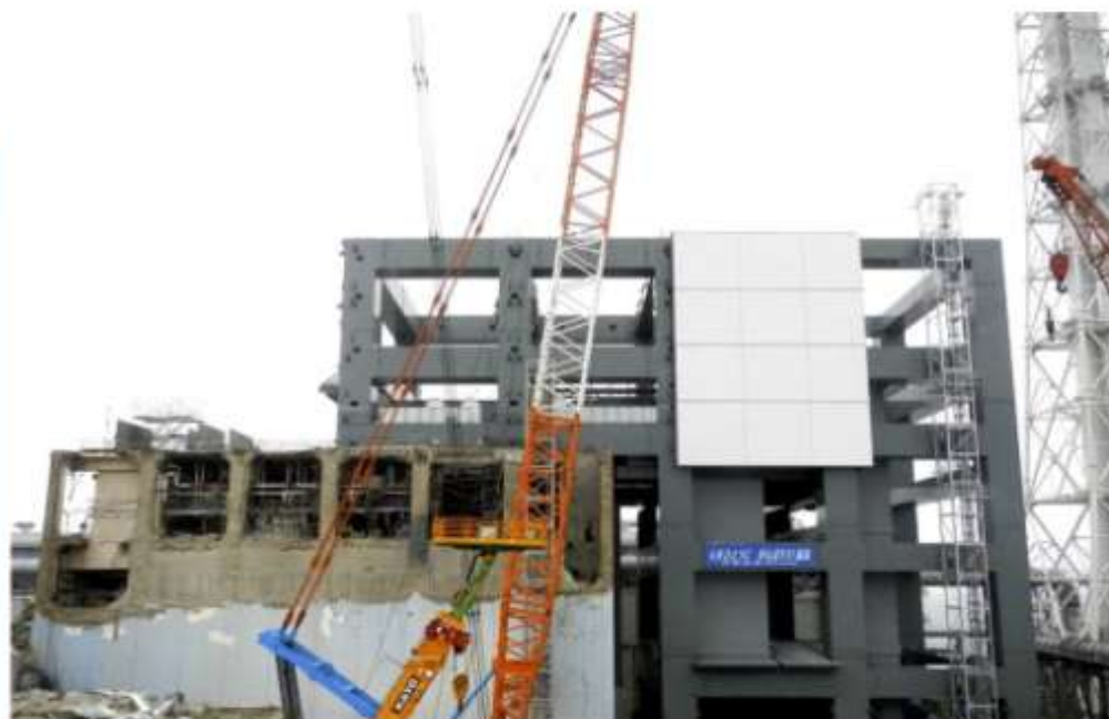
燃料取り出し用カバー(平成25年5月29日現在)
