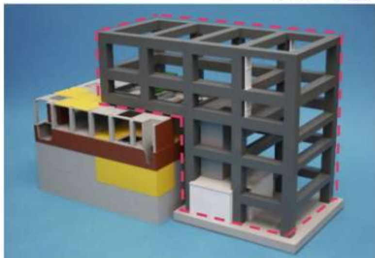
燃料取り出し用カバー鉄骨建方の完成（赤枠）
